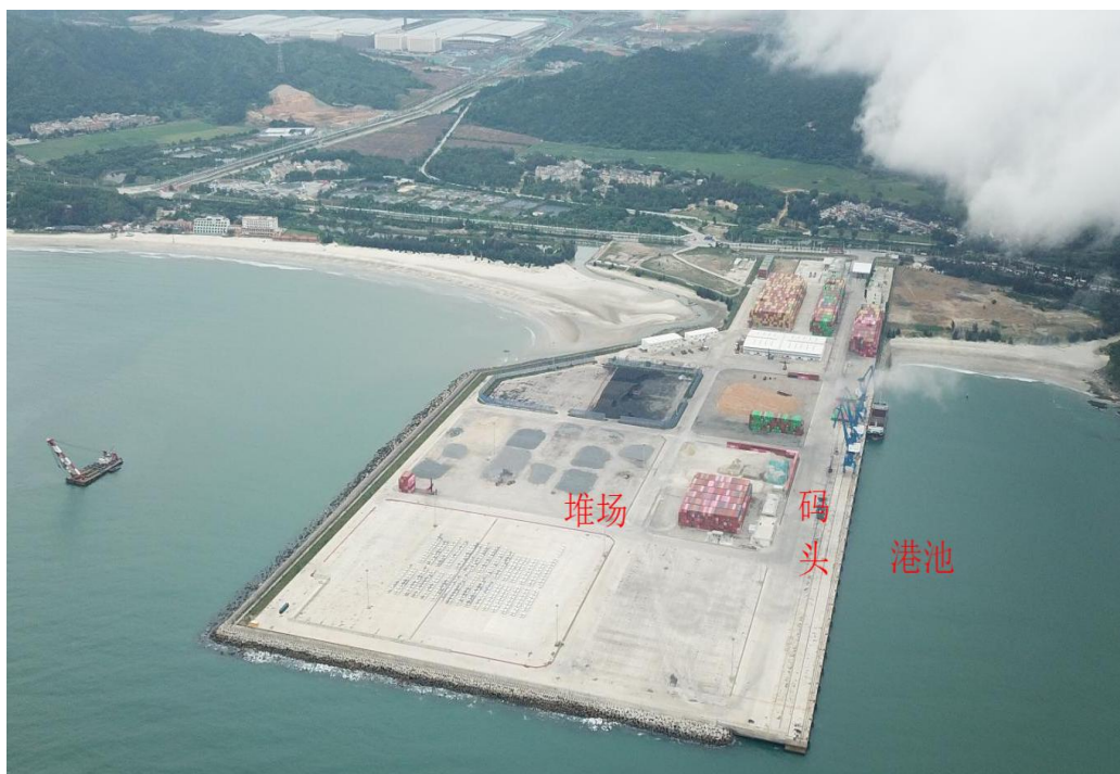
图 3.1-2a 一期工程实际建设情况航拍图
